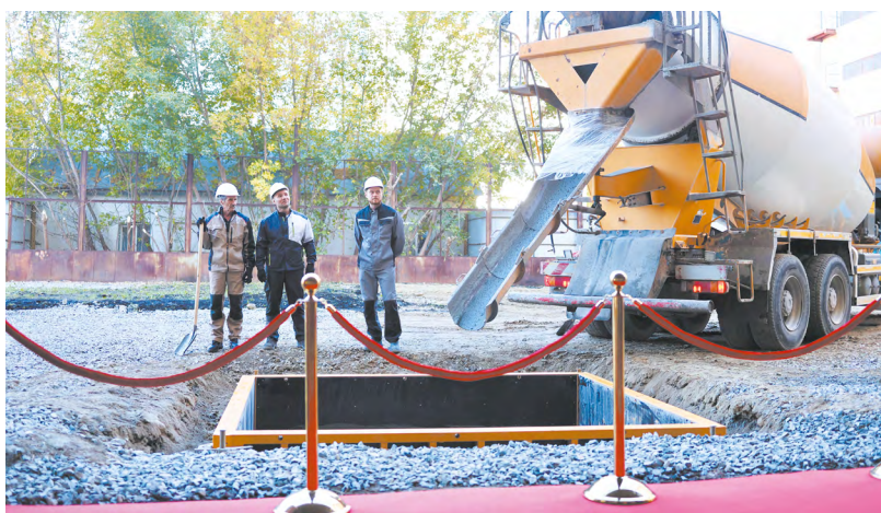
▲ 300 метров над Уралом: в уральской столице началось строительство 75-этажного небоскреба «Парус». Торжественная церемония, посвященная старту работ, прошла 30 сентября рядом с бизнес-центром «Высоцкий» Фото Ирины Ильиной
