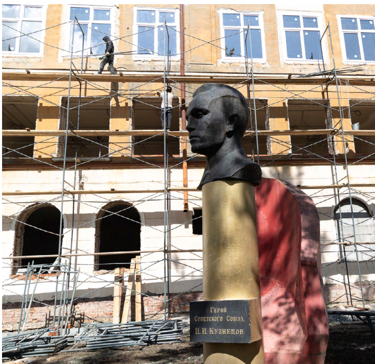
▲ В старейших учебных заведениях Уралмаша – школах №68 и №72 – ведется капитальный ремонт. Фото: Елена Ельцова
