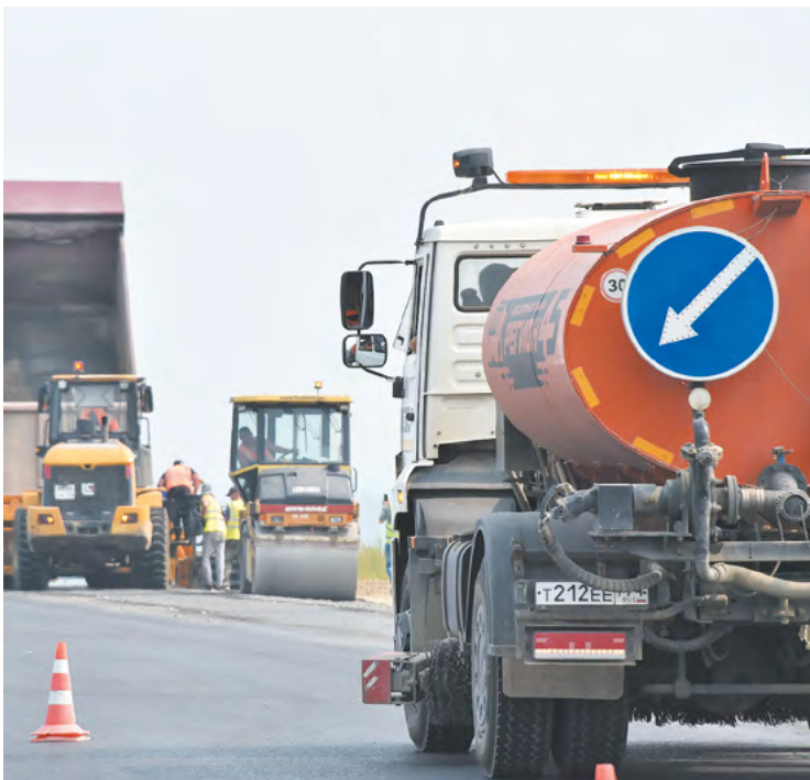
▲ Капитальный ремонт автодороги Нижняя Тура — Качканар опережает график более чем на два месяца. Фото: Борис Ярков
